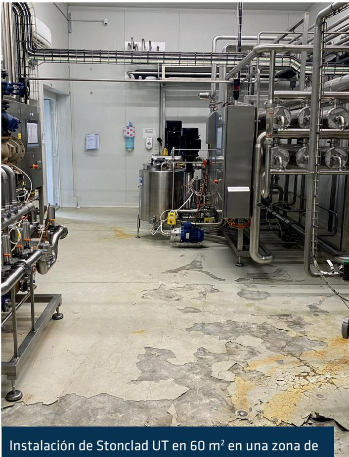
Instalación de Stonclad UT en 60 m<sup>2</sup> en una zona de difícil ejecución
